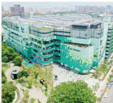
LaLaport台中(北棟)結構體工程
