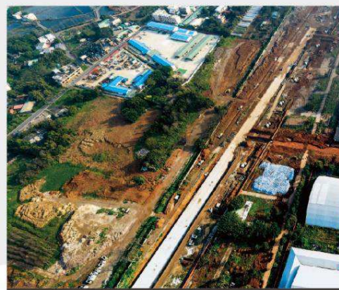
桃園航空城計畫區段徵收工程 D2分標統包工程
